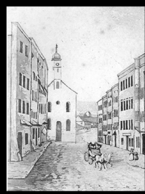
Franziskanerkirche (1686-1855) - Auftrag des Neubaus der Franziskanerkirche (sollte größer als die St.-Anna-Kapelle sein) - Baumeister: Giovanni Spazzo aus Como und Leonhard Uttner
